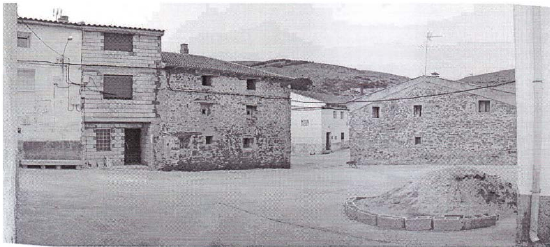
Lo que queda de las cuatro esquinas
