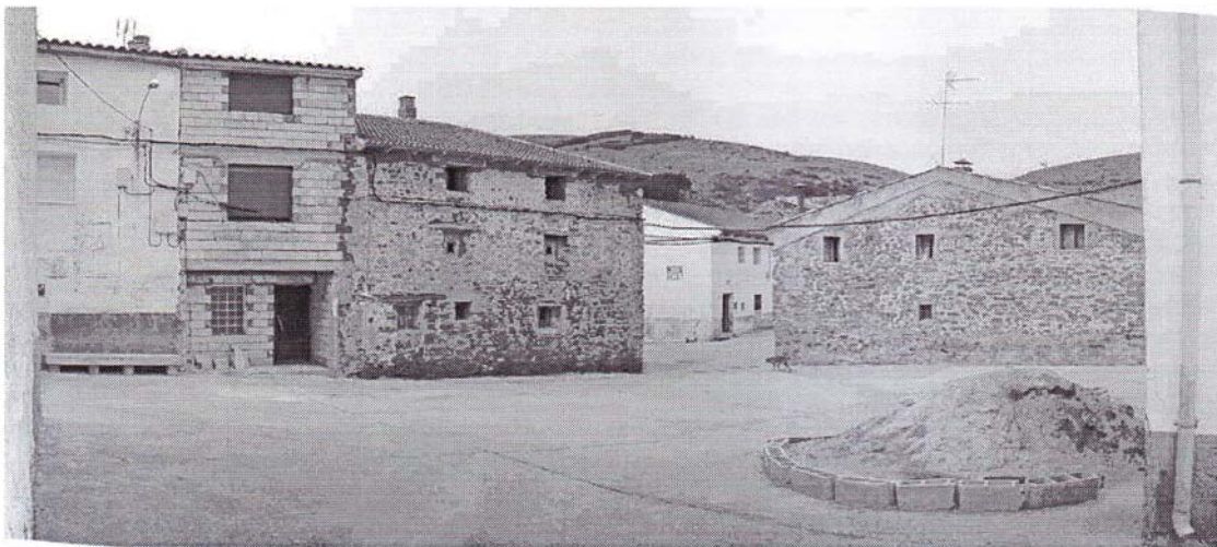
Lo que queda de las cuatro esquinas
